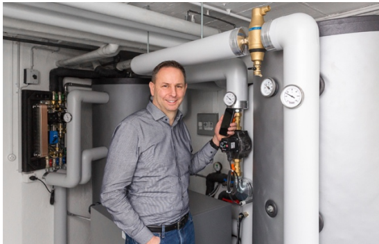
Ralph Seewald accanto al nuovo impianto di riscaldamento di casa
