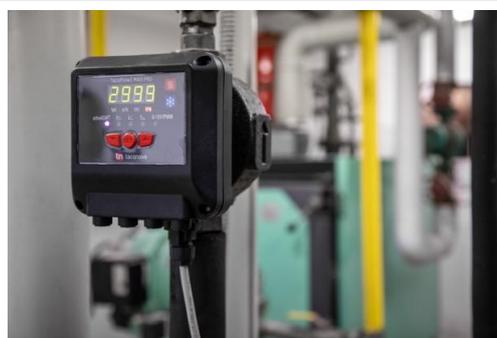
TacoFlow3 Max Pro è caratterizzato da un alto grado di robustezza grazie ad un silenzioso motore sincrono a magneti permanenti. Rappresenta la soluzione all-in-one ideale per il riscaldamento, il raffreddamento e le applicazioni solari, che copre anche gamme di potenza più ampie.
