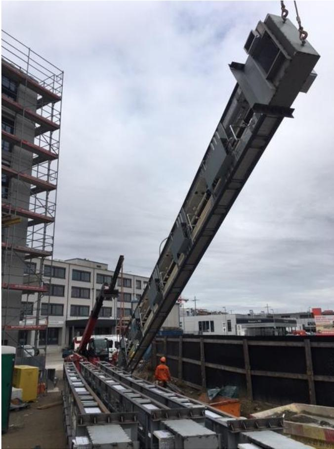
Gli impianti premontati, del peso di circa due tonnellate, sono stati trasportati nell'edificio con una gru. Poiché l'hotel si trova accanto all'aeroporto di Zurigo, è stato necessario ridurre l'altezza massima della gru.
