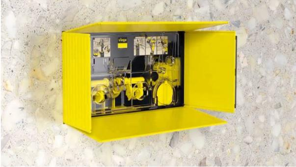
IT\_PR\_220628\_Viega\_Prevista\_006.jpg: Viega Prevista La rimozione della protezione da cantiere e il suo taglio a misura, tramite un comune cutter consentono un accesso sicuro e completo all'interno della cassetta (foto: Viega)
