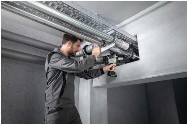
IT\_PR\_220628\_Viega\_sistemi\_a\_pressare\_004.jpg: Compatta, leggera e dotata di una testa completamente ruotabile, Pressgun 6 Plus è la pressatrice ideale per alleggerire le operazioni quotidiane in cantiere. (foto: Viega)
