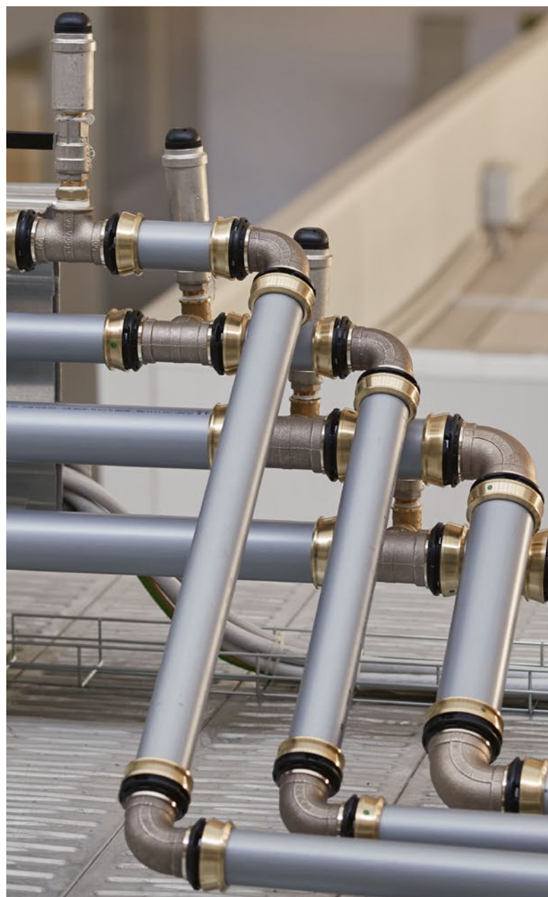
Particolari dell'installazione con tubi multistrato e raccordi a pressare di bronzo al silicio di massima qualità Viega Raxofix.
